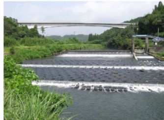
写真 1.3.1 林田堰（支川串良川）
