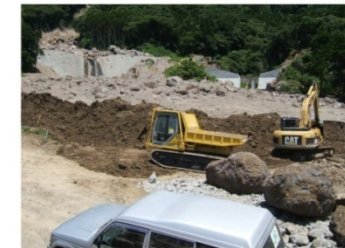
写真 4.3.17 遠隔操縦による危険箇所での 災害復旧作業
