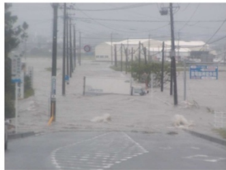
写真 1.2.12 肝属川右岸 8,000 付近 堤内地浸水状況
