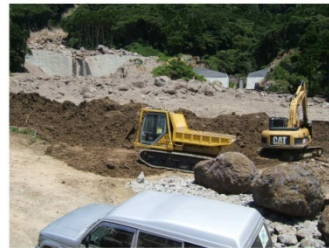
写真 4.3.17 遠隔操縦による危険箇所での 災害復旧作業
