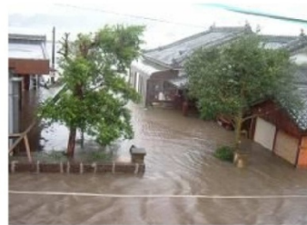
写真 1.2.13 肝属川左岸 10,000 付近 堤内地浸水状況
