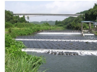
写真 1.3.1 林田堰（支川串良川）
